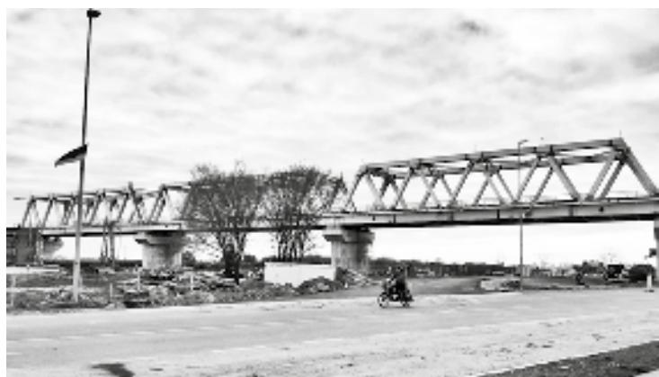
četiri i po metra. Svi stubovi novog železničkog vijadukta u Vrbasu su armirano-betoniski, dok se čeličnim
